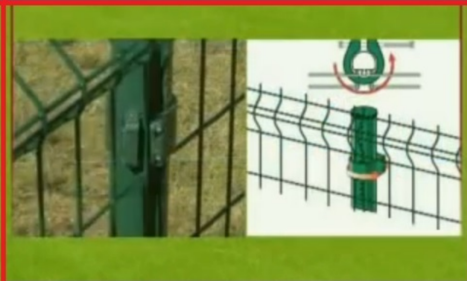
Fixer le panneau dressé au poteau précédent
