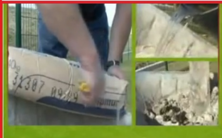
Préparer votre béton (éviter le stabilisé)
