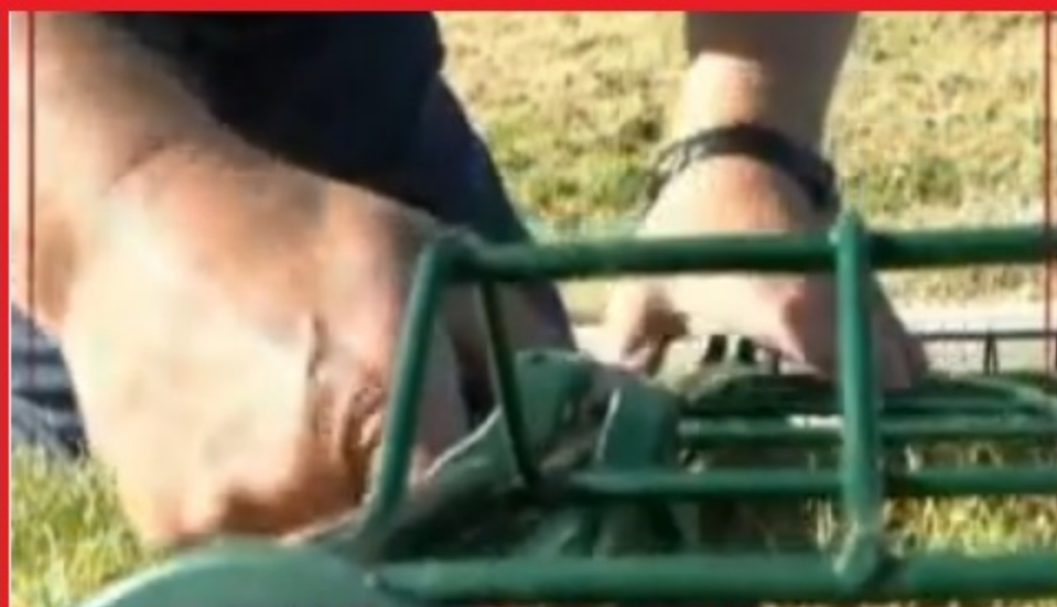
Placer le panneau dans l'encoche du poteau, en passant par le collier
