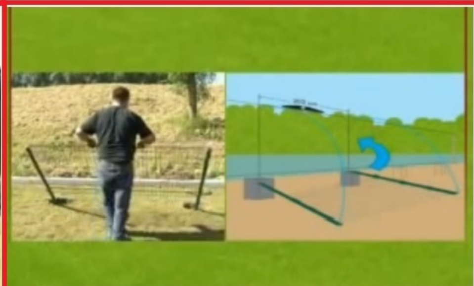
Dresser les poteaux et le panneau assemblés
